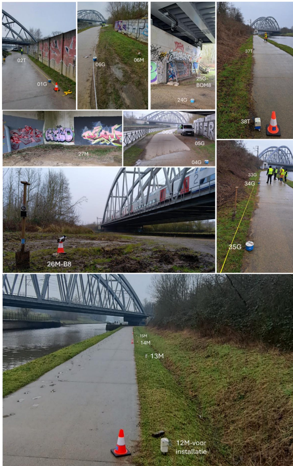
Figuur 11 : Enkele overzichtsfoto's van sensoren tijdens de meetcampagne tussen de spoorwegbruggen.
