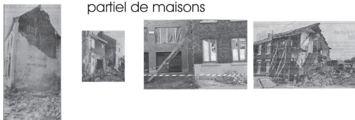
Figure 4 : Dégâts typiques observés lors du tremblement de terre de Liège du 8 novembre 1983
