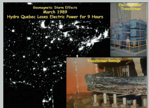
Figuur 5: Deze transformator bij de Salem kerncentrale (New Jersey, USA) werd door de geomagnetische storm van 13 maart 1989 fataal beschadigd. Door dezelfde storm zaten in Québec 6 miljoen mensen 9 uur zonder stroom. (© PSE&G)
